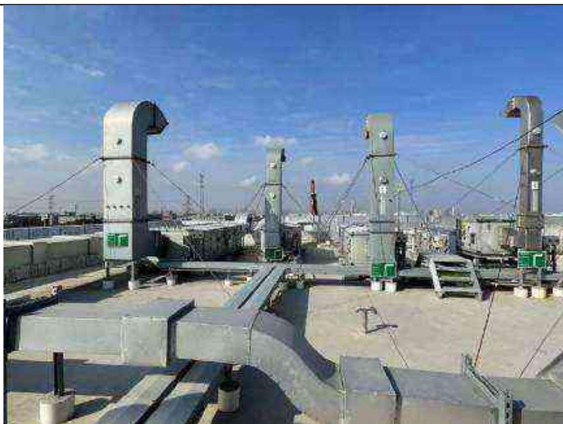
图 3-1 QC 大楼楼顶废气处理装置
